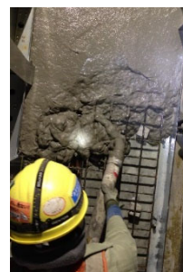
(d) 靱性モルタルの打設
