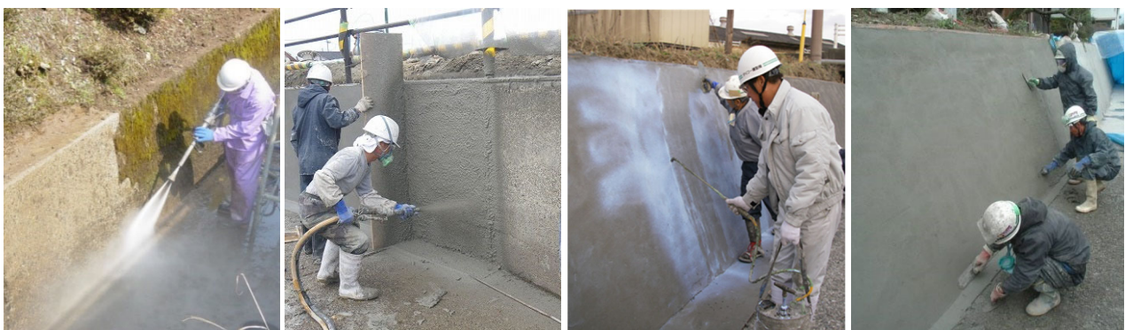
(a) WJ 工法で表面研掃 (b) 靱性モルタル吹付け (c) アクリル系エマルジョン塗布 (d) コテ仕上げ
